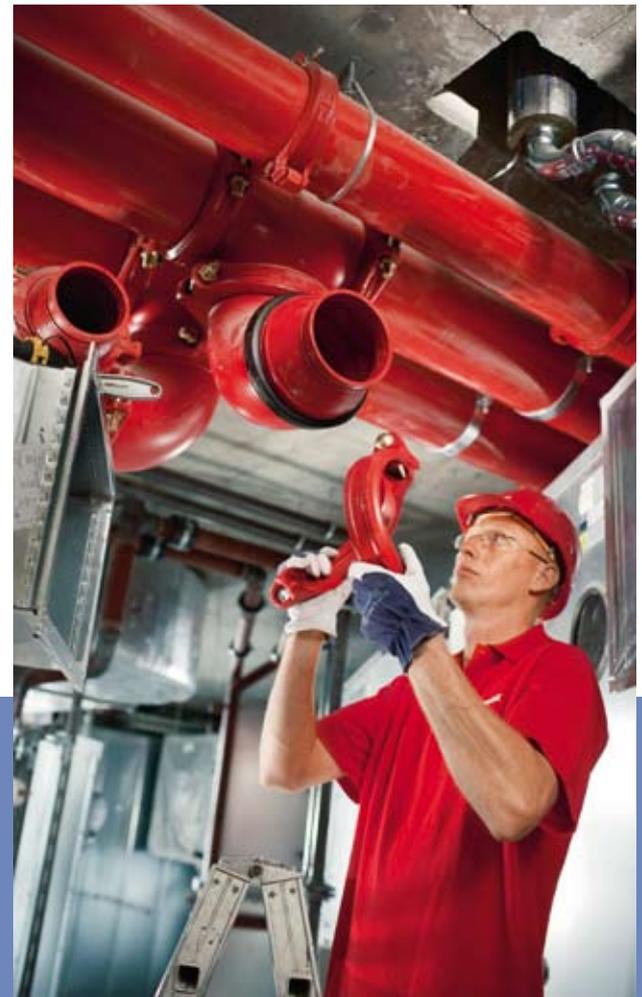
I giunti e raccordi PicoFix sono certificati VdS, listati UL e approvati FM.
